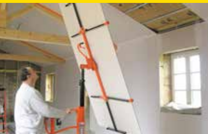
Pose sous rampants
